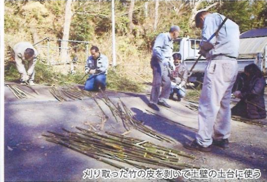
刈り取った竹の皮を剥いて土壁の土台に使う
