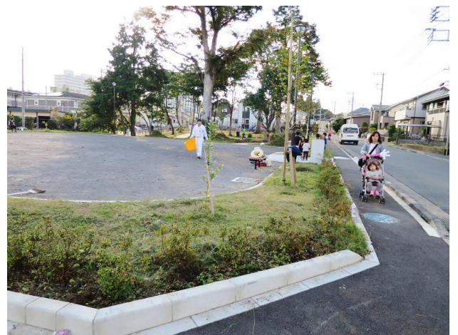
東北角側 作業後
