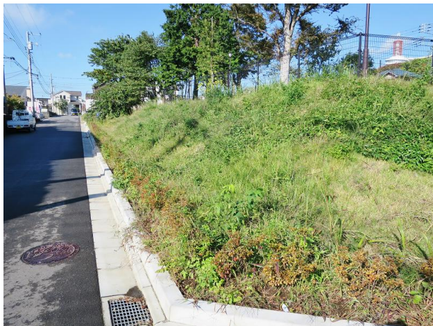
南側斜面 作業前
