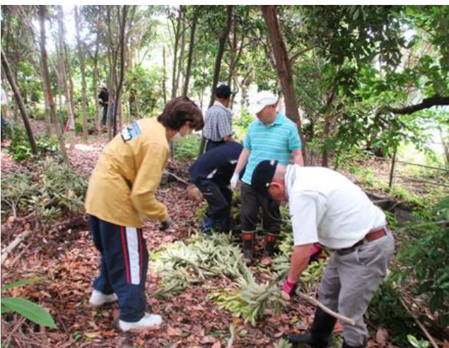
剪定した枝を整えて地盤の「しがら」（土留め）に利用する。
