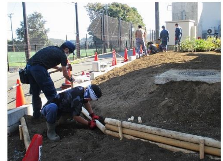
北東の角の斜面には、丸太を組んで土留めを設置する！
