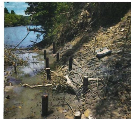
民地河岸際に焼き杭を千鳥に打ち、停滞した土中の水の動きを促し、湧き出しをつくる。
